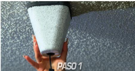
Cubra las cabezales aspiradores. Bed Bug Heat Doctor-PrevSol no es responsable por ningún daño si la cabezal aspirador no está cubierta. Recomendamos el uso de cubierto para el grifo de afuera disponible en cualquiera tienda de mejoras para el hogar. El cubierto para el grifo de afuera mantiene la cabezal aspirador a 30 grados más frío que la temperatura del cuarto.
