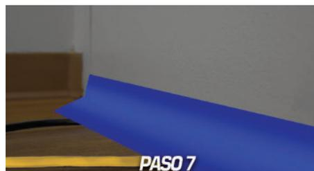
El cable negro de 220 voltio y el cable amarillo de 120 – voltio deben ser colocados debajo de la puerta para llevarlas al cuarto del lado. Selle el cuarto con cinta azul para pintores para mantener una junta impenetrable para que el aire no se pueda pasar. Las personas deben salir del cuarto mientras el cuarto recibe el tratamiento.
